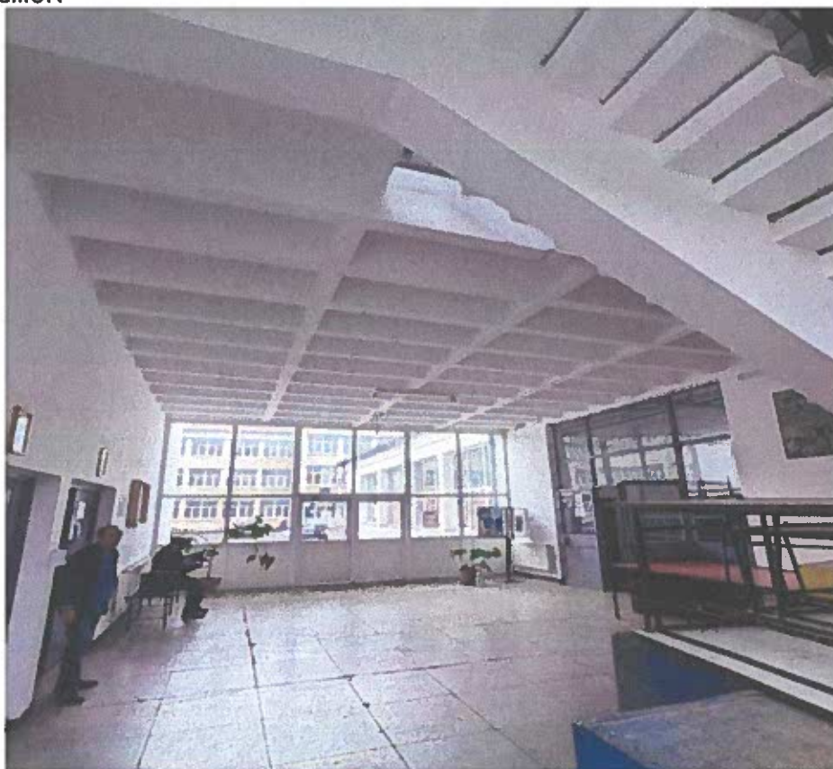
Poza 4. Poza din holul principal se observa planseul cu nervuri si scara
