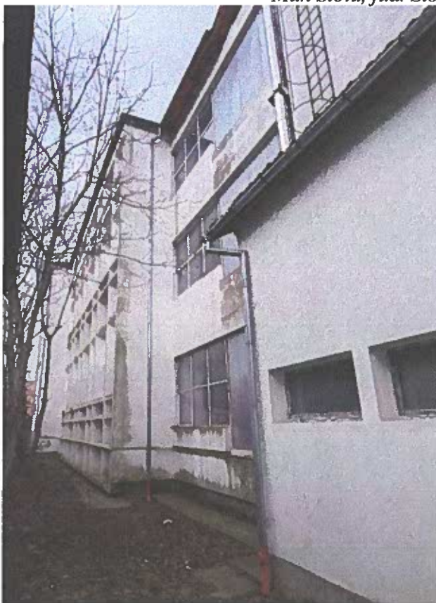
Poza 3. Poza dinspre centrala termica. Se observa unele degradari ale tencuielilor.
