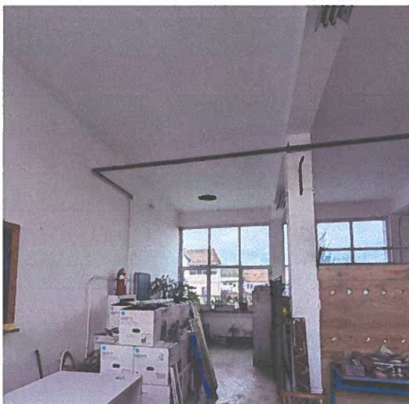
Poza 6. Poza corpul Atelier electric. Se observa structura in cadre si in partea stanga peretii din beton armat.
