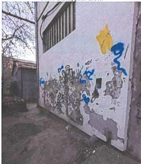
Poza 11. Poza fatada posteriora pe zona post trafo. Se observa ca termoizolatia a fost vandalizata.
