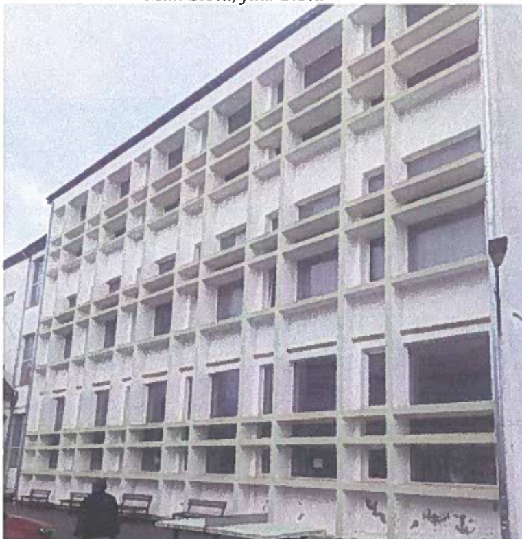
Poza 1. Fatada principala se observa brisoleiurile de la nivelul laboratoarelor.
