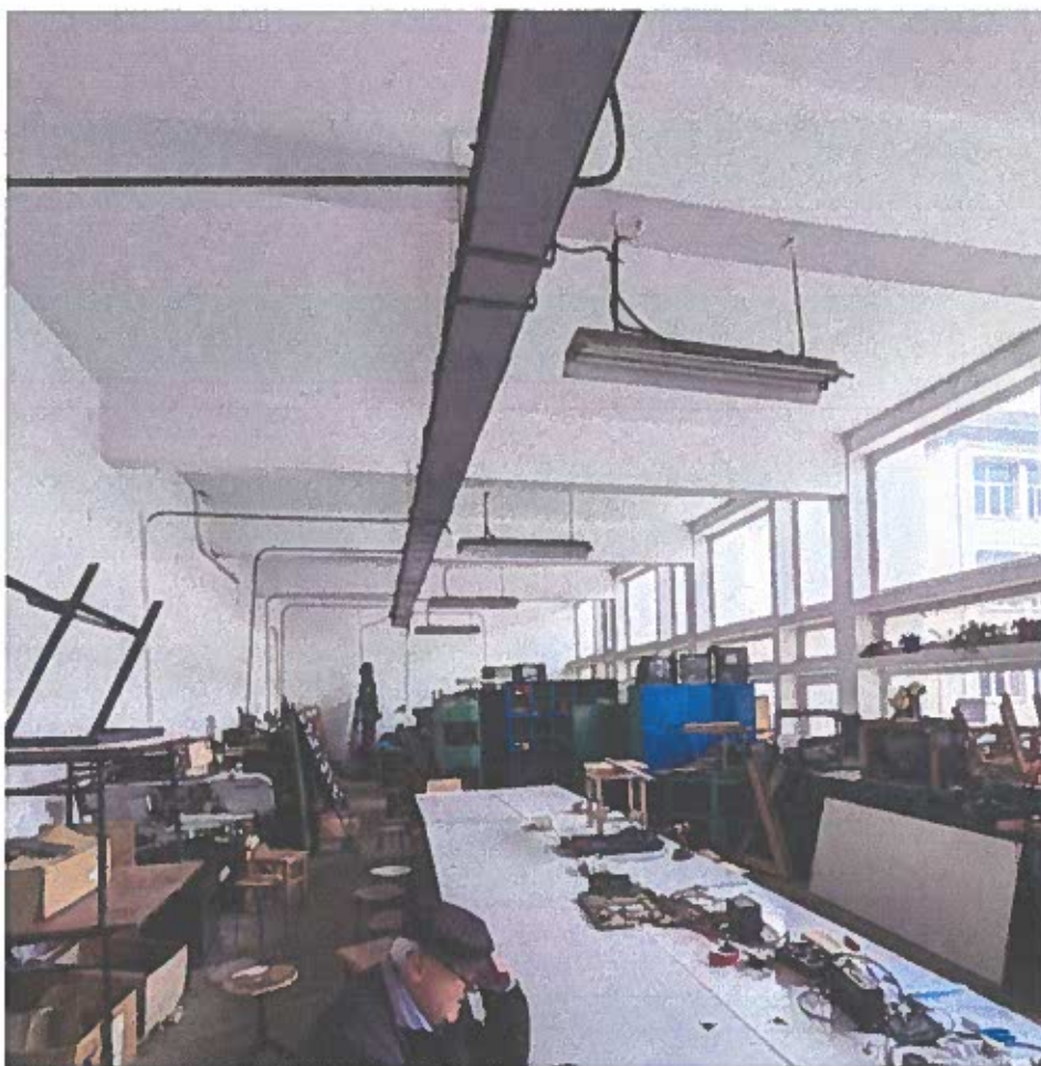
Poza 7. Poza din corpul P+2E, la P Atelier Electromecanica. Se observa peretele median de zidarie si cadrele din beton armat.
